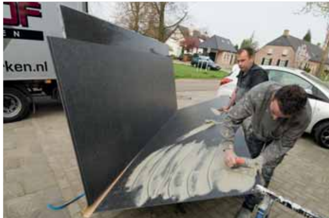
04 Gluing of the slab 04 Incollaggio della lastra
