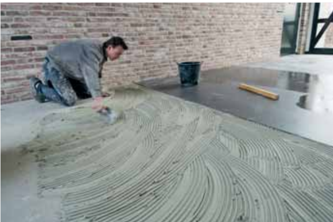
06 Double-gluing of the flooring 06 Doppio incollaggio della soletta
